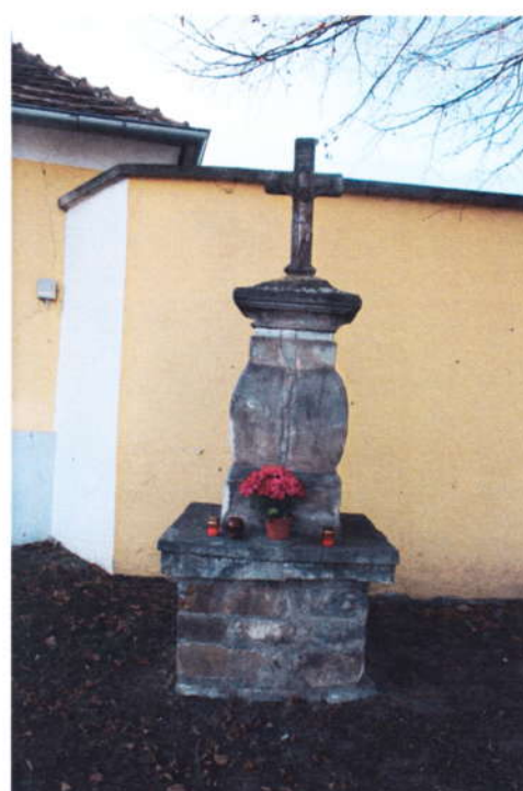
oprava drobných sakrálních staveb
