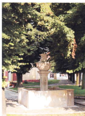
oprava historické kašny
