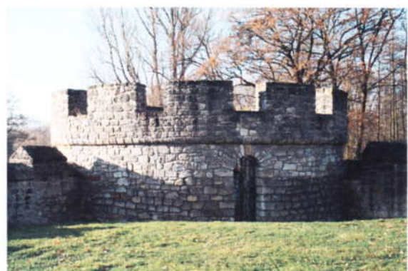
oprava hradebních zdí
