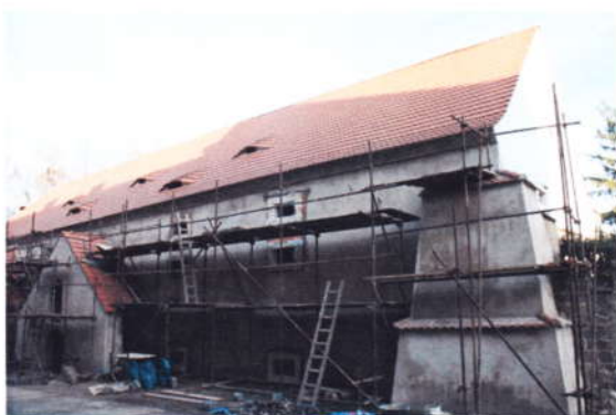
rekonstrukce sýpky střecha
